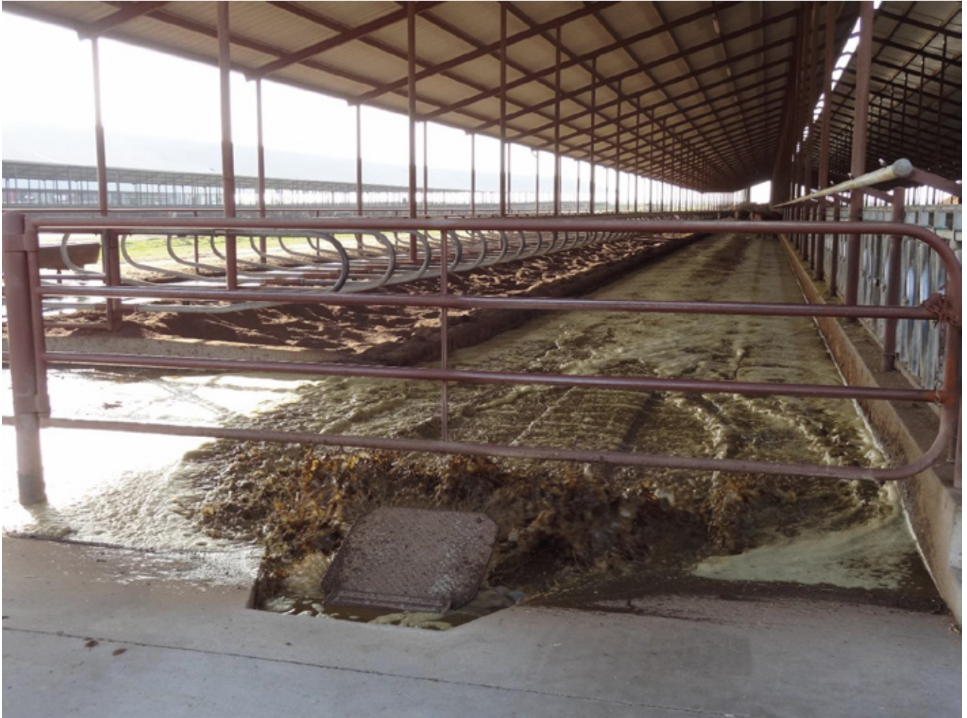
Válvula flush de bisagra realizando flushing en pasillo de freestall
